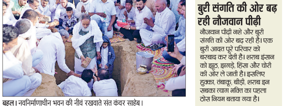
बहल। नवनिर्माणाधीन भवन की नींव रखवते संत कंवर साहेब।
